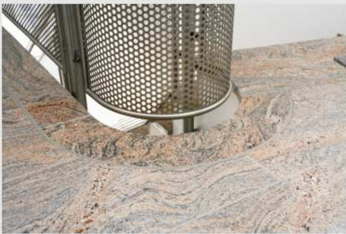
Treppenanlage aus Juparana Colombo mit halbkreisförmigem Treppenauge. Boden an Fries angepasst.
