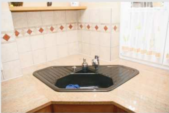
Küchenarbeitsplatte aus Ivory Orange mit Sonderform. Eingesetztes Keramikspülbecken. Integrierte Fensterbank. Rückwand gefliest.
