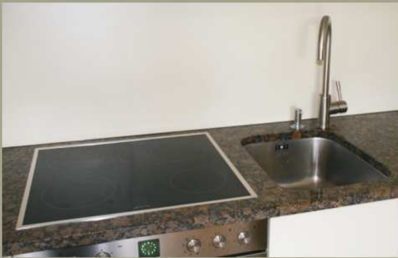
Küchenarbeitsplatte aus Baltic Brown mit Unterbaubecken, Edelstahlarmatur und Spülmitteldispenser. Vorderkante leicht gerundet R=5mm.
